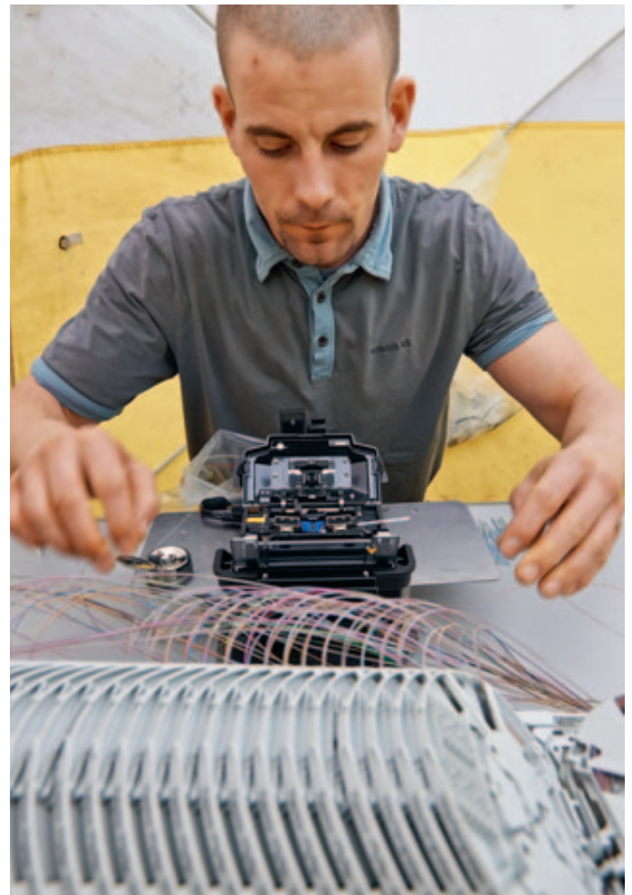
Die Glasfasern werden in Handarbeit verbunden, also «gespleisst».
